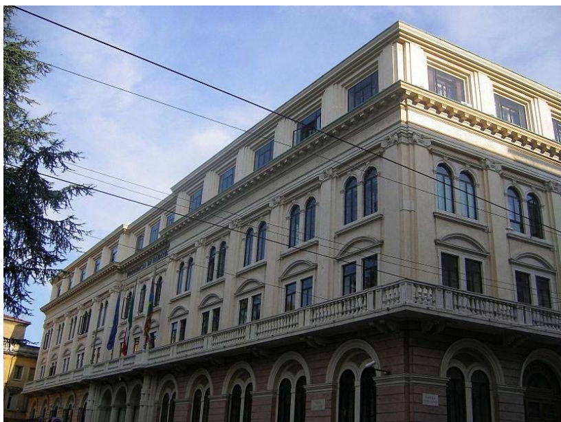
Chiesa di Santo Stefano - Prefettura. Chiesa demolita
